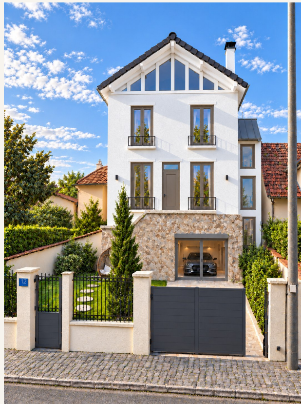
APRÈS — VUE PROJETÉE, FAÇADE SUD-OUEST
